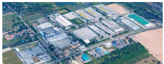
AEROFLEX CO., LTD., RAYONG, THAILAND (100,000 M 2 )
